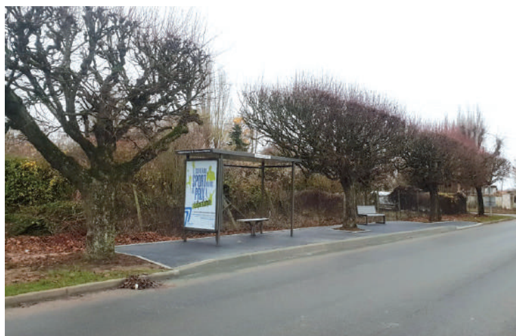
Mise aux normes des 6 abris bus pour personnes à mobilité réduite
