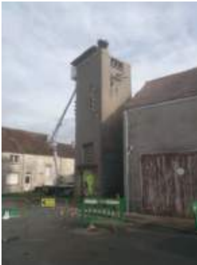
Démolition du poste de transformation électrique à l'angle des rues Madame Hégot et Sadi Carnot.
